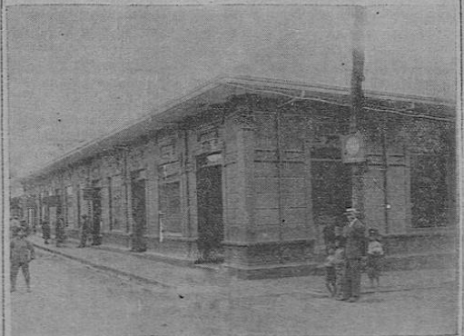
Construcción de cemento armado de la casa comercial de Rivera y Compañía, conocida con el nombre de "La Copa Blanca". Ocupando la propia esquina está la sección bancaria de la misma casa.
